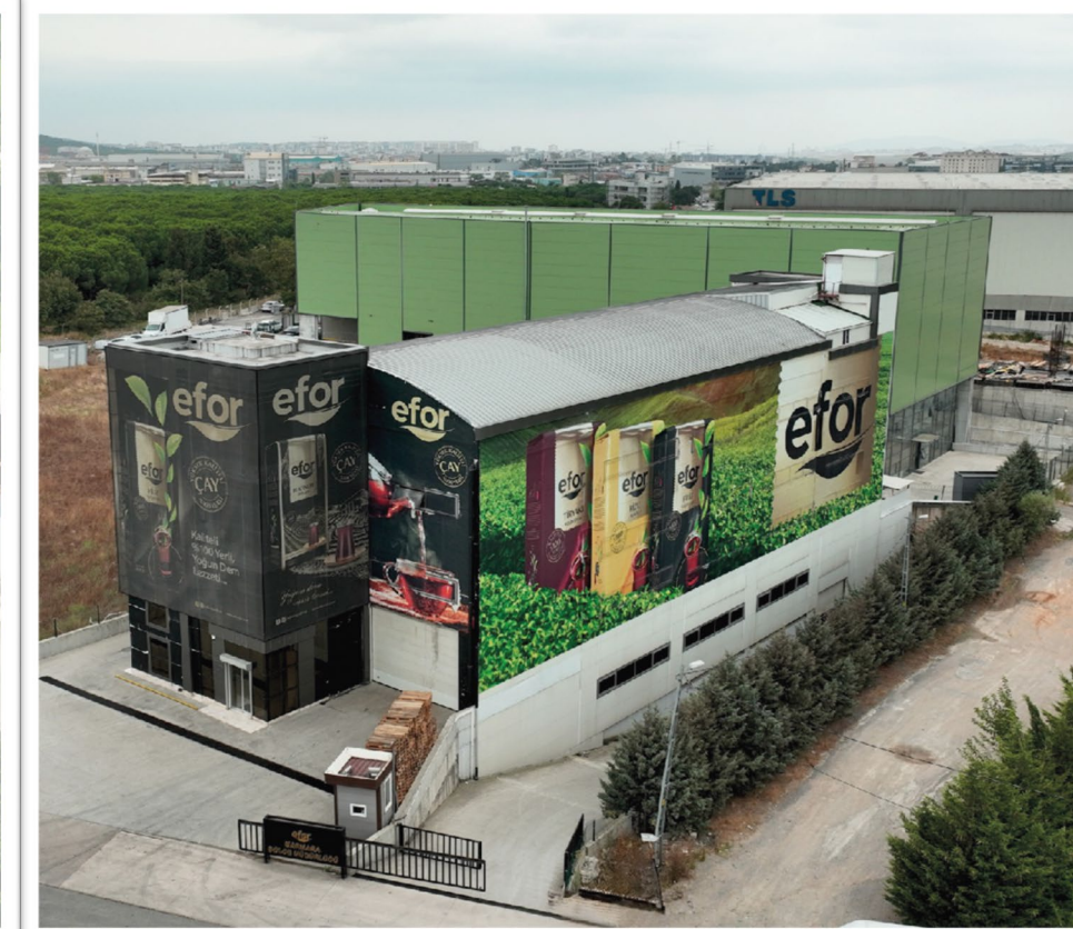
İSTANBUL / TUZLA ÇAY PAKETLEME TESİSİ
