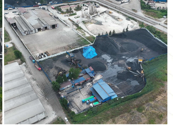
Samsun K     tesisi: Tesis Alanı: 12.380 m2 Tesis Kapasite: 512 Ton/G    
